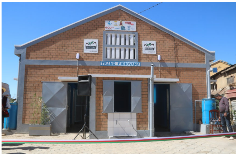
Photo 12 : Bloc sanitaire dans la Commune urbaine de Fianarantsoa
