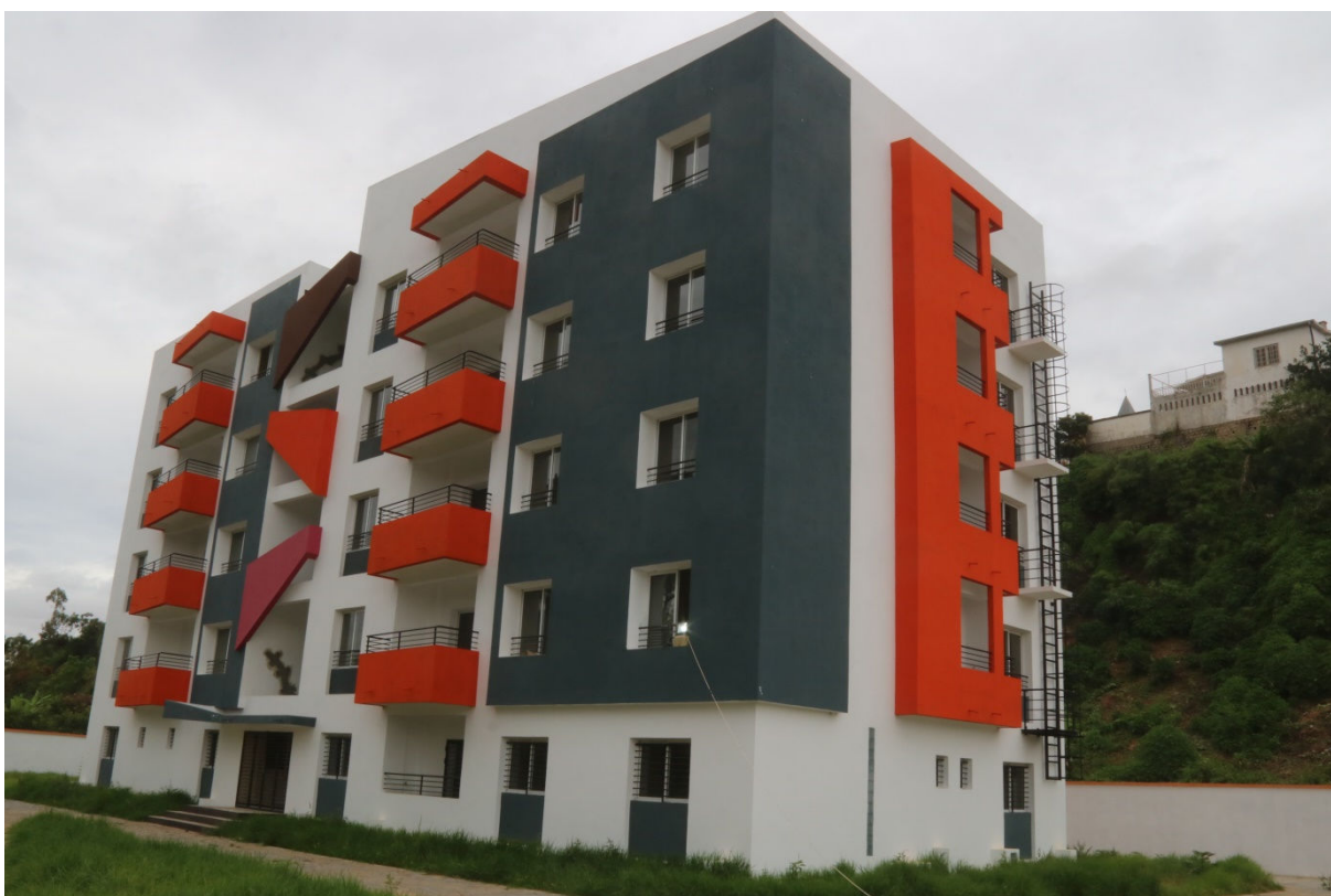
Photo 14 : Bâtiment R+4, Commune urbaine Fianarantsoa
